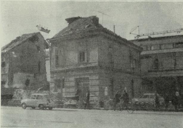
Sl. 5. Porušena hiša v ulici Maršala Tita (južni del)
