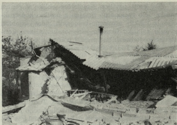
Sl. 16. Porušeni opečni paviljon
