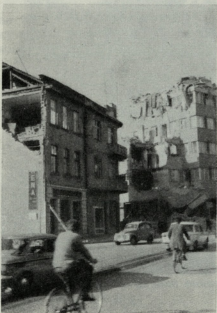
Sl. 11. Porušena stavba v ulici Maršala Tita
