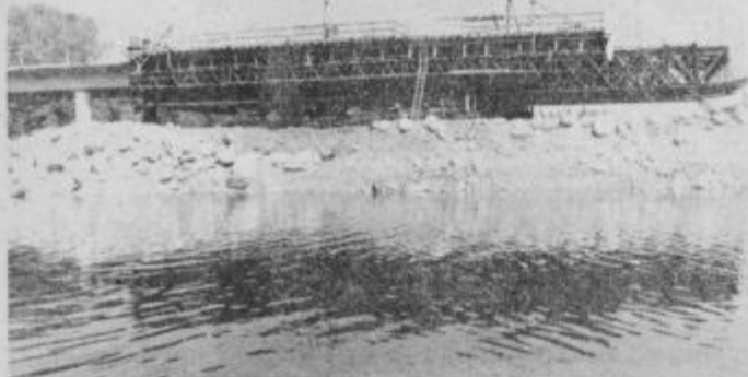
Priprava predzadnje konstrukcije borlskega mostu je bila že tako daleč, da so lahko prvi vztrajneži po lestvi že šli na drugo stran
