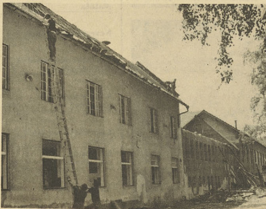
Julijsko soboto so prostovoljci res hitro začeli z rušenjem stare »menze«. (foto: Z. Novak)
