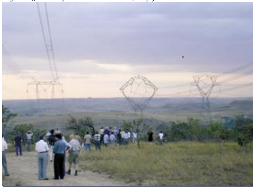
Pogled na 500 kV daljnovode različnih izvedb, izhajajočih iz RTP Samambaia.
