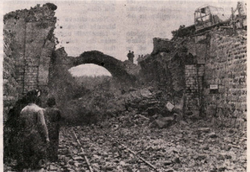
Pogled na predor po končanem miniranju
