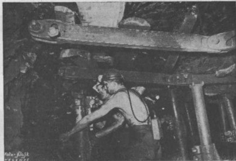
Uporaba jeklenih stropnikov olajša delo rudarja, poveča se storilnost dela in nadalje zmanjšuje porabo jamskega lesa
