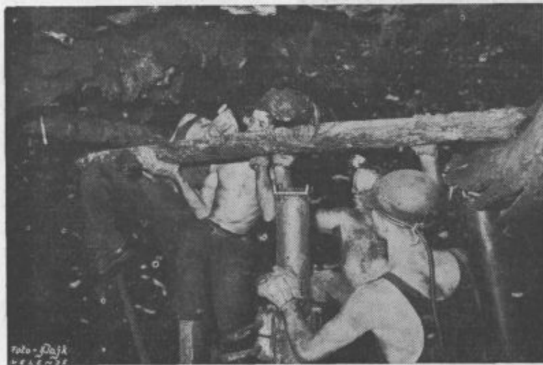
Vgrajevanje lesenih stropnikov in podvlek v stropu širokega čela je bilo težavno in precej zamudno
