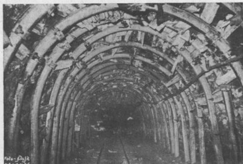
Proge, podgrajene z jeklenim ločnim oporjem, kar mnogo doprinaša k znižanju porabe jamskega lesa, znižanju šihov na vzdrževanju, povečanju jamske storitve ter skupnemu znižanju proizvodnih stroškov
