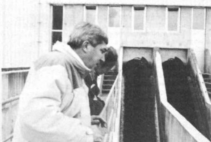
V centralni čistilni napravi Šaleške doline očistijo letno 4,3 milijonov kubičnih metrov odpadnih voda, zmogljivosti pa so s tem izkoriščene 40 odstotno
