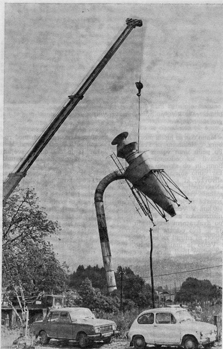
Del silosa je v »trdnih rokah« Podiranje silosa na bivši Gorjani
