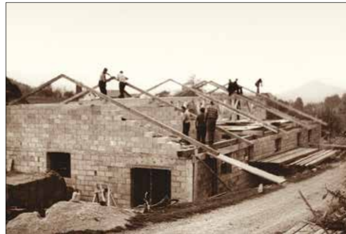
Gradnja hleva pri Korenčkovih leta 1978 Arhiv: Jože Debeljak
