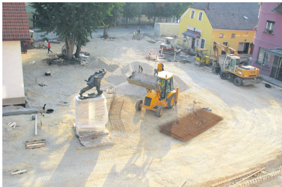
Prenovitelna dela na Trgu svobode v Šoštanju bodo končana do konca septembra.
