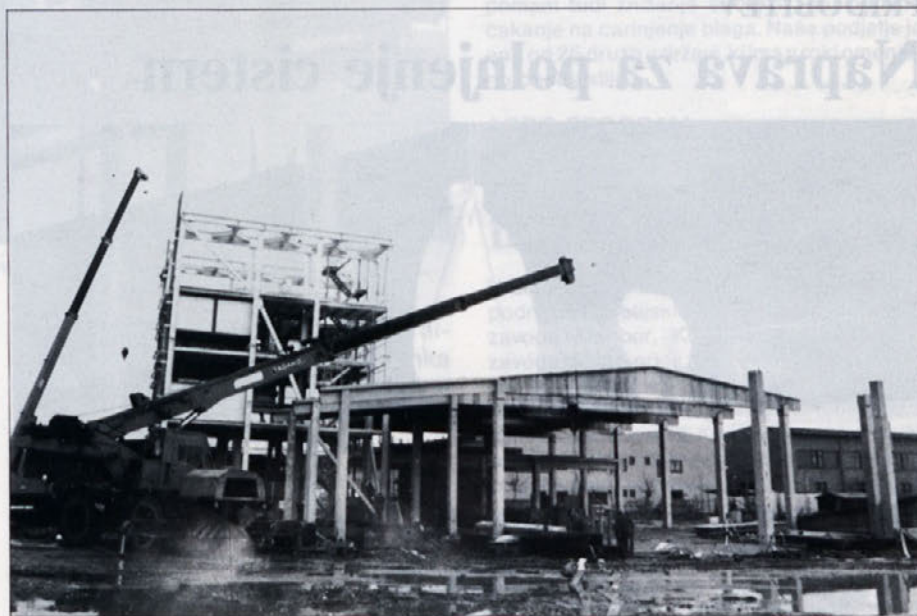
Obrat v izgradnji
