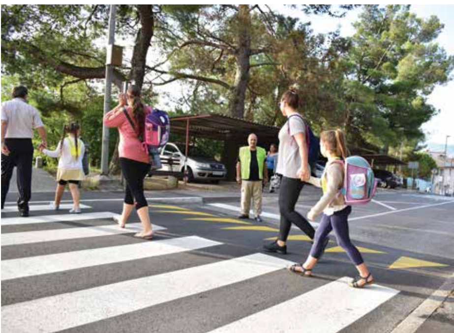
Varnost pešcev je izboljšala trapezna ploščad s prehodom za pešce pri križišču med Srebrničevo in Regentovo ulico. / La sicurezza dei pedoni è stata implementata dalla piattaforma trapezoidale con passaggio pedonale all'incrocio fra la Via P. Srebrnič e la Via I. Regent. (Foto: Uredništvo / La Redazione)
