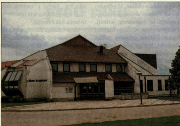
Dom krajanov Gomilskem že pod novo streho
