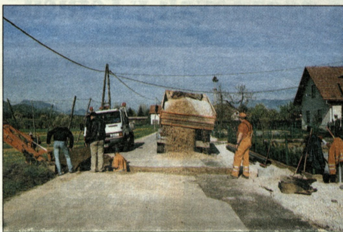
Kopanje jarka za odvajanje meteorne vode
