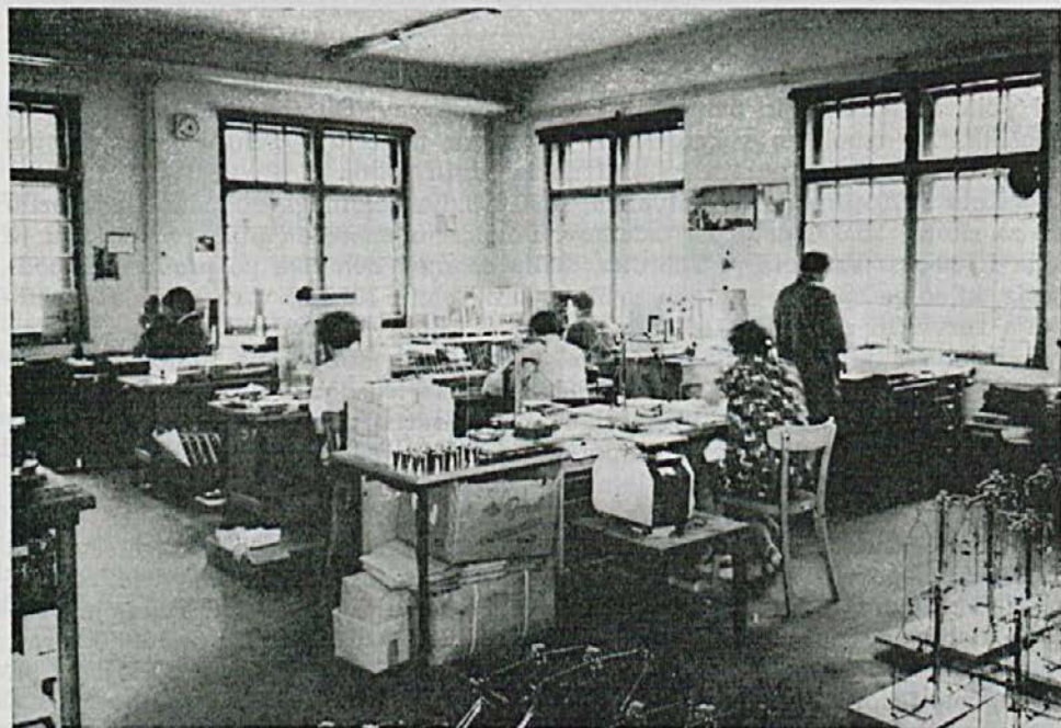
Montaža v TEHTNICI
