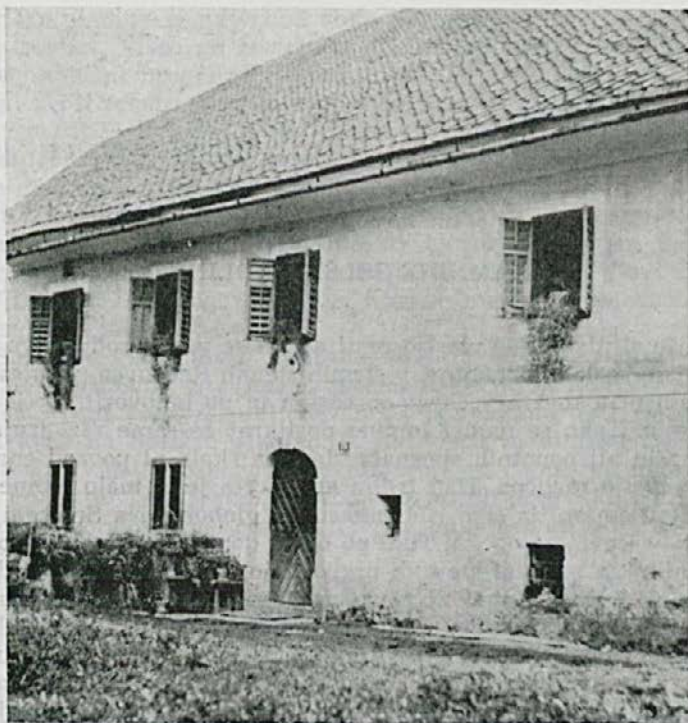
Sl. 1. Kamnita streha, pokrita s ploščicami srednjepermijskega skrilavca v Dolenji vasi št. 26. Ploščice so slabše kvalitete in jih ni bilo mogoče bolje obdelati.
