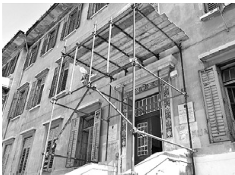
V triletnem načrtu del je tudi postavka za obnovo stavbe zavoda Stefan
