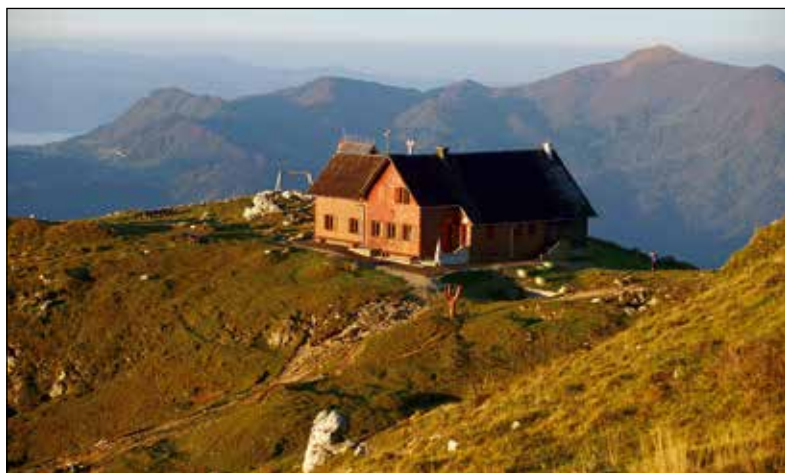
Leta 2010 je bil v celoti porušen prizidek iz leta 1987. Na istem mestu je bil zgrajen nov in dodatno podkleten prizidek. Tu so v kletnih prostorih sanitarije in strojnica s črpalkami. V pritličju je četrta jedilnica z 20 sedeži, v nadstropju pa oskrbnikovo stanovanje. Poleg prizidka je bila zgrajena čistilna naprava in zbiralnik vode velikosti 60 kubičnih metrov.
