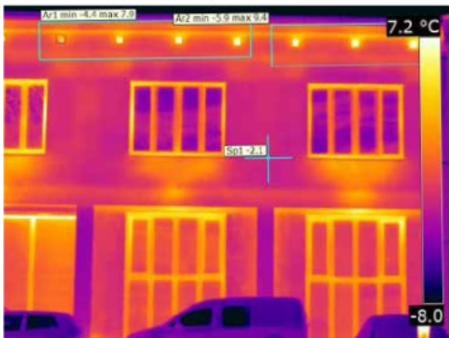
Termovizija upravne zgradbe Taluma
