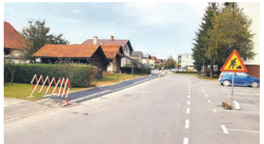
Gradišnikova po obnovi
