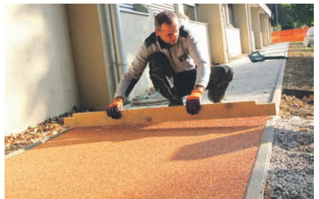
Polaganje lepljenega marmornega prodca, novega inovativnega materiala za pohodne poti.
