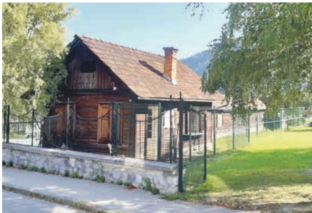
Propadajoča stavba je začela predstavljati grožnjo za varno otroško igro
