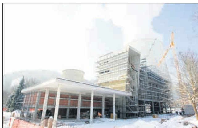
Pred Tešem že raste nova upravna zgradba.
