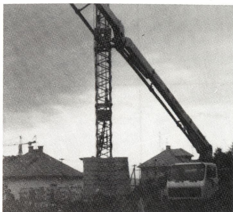
Gradnja poslovne stavbe
