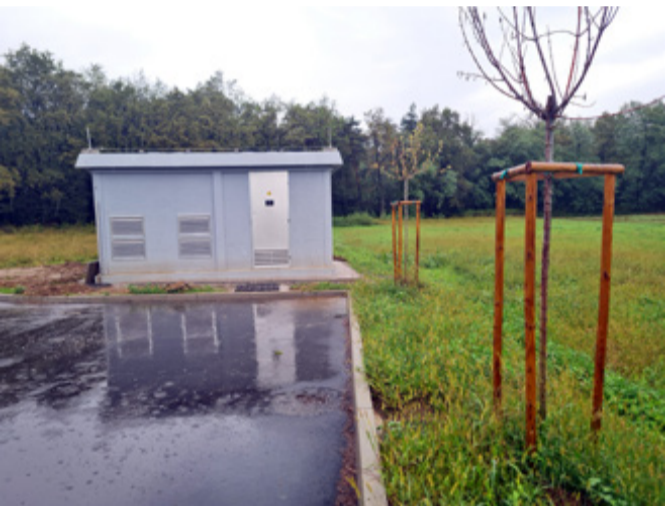
Foto: OU Z izgradnjo transformatorske postaje je v celoti zaključena izgradnja O.C. Novi Jork - IV. faza.
