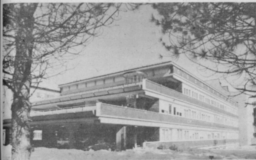
Nova bolnišnica Slovenj Gradec, v katero so vgrajena PVC okna po sistemu Kostroj.
