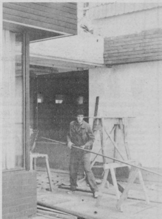
Ob hotelu Dobrava v Zrečah je že pod streho večnamenska dvorana
