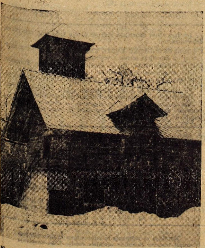
Nov gasivski dom na Koroški Belli je pod streho. Toda doslej so urejeni šele spodnji prostori, ki jih že uporabljajo. Prebivalci Koroške Bele pa so v zadregi, ker jim je zmanjkalo sredstev, da bi si dokončno uredili tudi prostore v prvem nadstropju, ki bi jih predvsem potrebovale družbene organizacije. Kljub temu pa tamkajšnji prebivalci upajo, da jim bo v kratkem s pomočjo občinske gasivske zveze, stanovanjske skupnosti in KZ Dvje-Mojstrana uspelo zbrati manjkajoča sredstva in da si bodo v najkrajšem času nov gasivski dom lahko dokončno uredili
