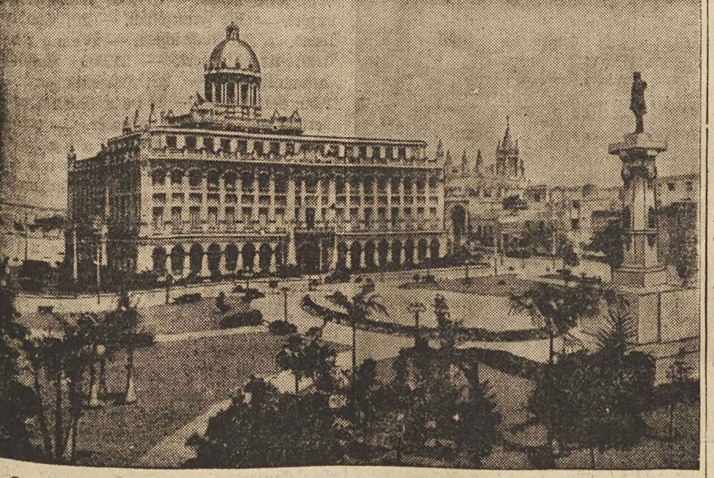
Der Palast des Präsidenten der Republik Habanna, auf dessen Dach eine Höllemaschine gefunden wurde. Der Sprengkörper war stark genug, den ganzen Präsidentenpa-
