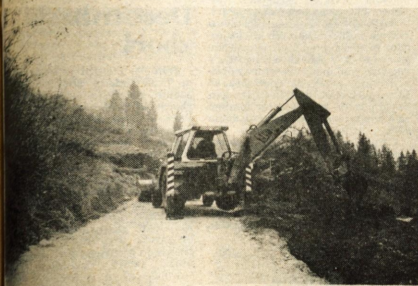
Na odseku ceste med Bohinjsko Belo in Obrnami na desnem bregu Save Bohinjke so minuli teden zabrnili stroji Cestnega podjetja Kranj.
