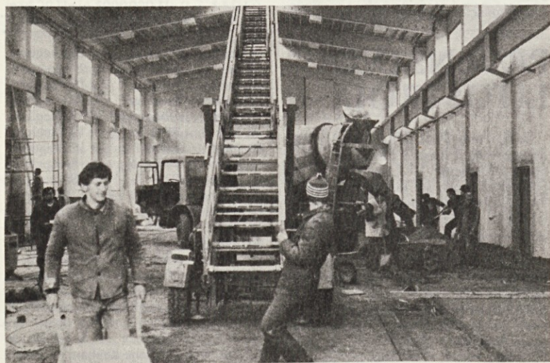
Notranjost poligonske hale Tomeksa za pripravo proizvodnje komaj 14 dni pred slavnostno otvoritvijo. Vsa gradbena dela na objektu so bila do otvoritve končana.
