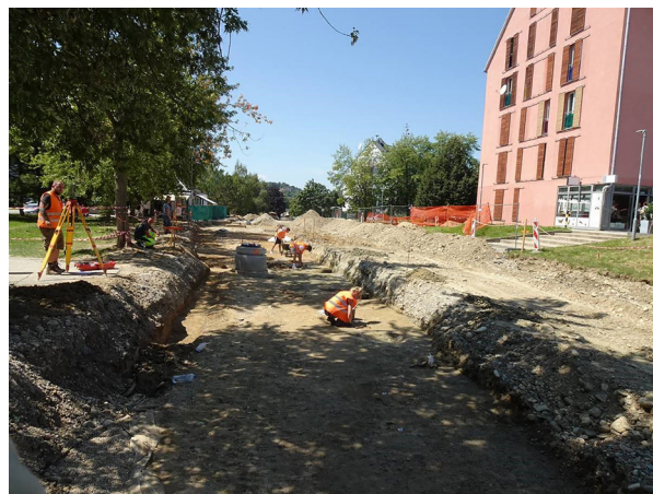
Slika 9 Pogled na najdišče.
