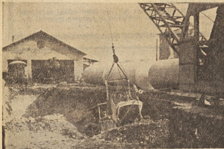
Ljubljansko podjetje »Petrol« gradi za ljubljansko železniško kurilnico tri cisterne za nafto, prostornine 50 kubičnih metrov, ki jo potrebujejo kurilnice za svoje Diesel lokomotive in motorke. Doslej so nafto prevžali trikrat dnevno, vendar ta nafta ni bila najbolj uporabna, ker mora nafta za Diesel lokomotive težati najmanj teden dni, da se ne zamašijo filtri
