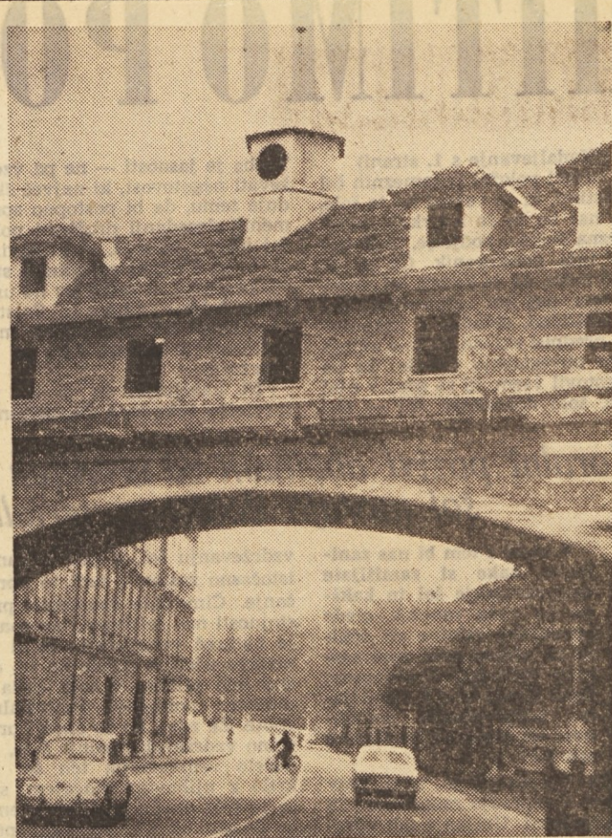
Ljubljanci in tuji lahko že nekaj mesecev občudujejo na Levstikovem trgu v Ljubljani na videz malce nenavadno stavbo oziroma neke vrste portal, ki se boči nad novo speljano cesto Ljubljana—Zagreb. Dela sicer še niso povsem končana, vendar pa gradnja že zdaj kaže, da bomo s tem pridobili privlačno in zanimivo urbanistično in arhitektonsko posebnost, ki bo temu delu Ljubljane nedvomno v starinski ambient Levstikovega trga. Zanimel, projekt in izvedba portala so delo ing. arhitekta profesorja Borisa Kobeta in inž. Lapajeta, po dokončani gradnji pa bo portal imel tudi svojo praktično vrednost, saj bodo v njem uredili več atelejev za slikarje in kiparje, ki bodo te pridobitve nedvomno veselili.
