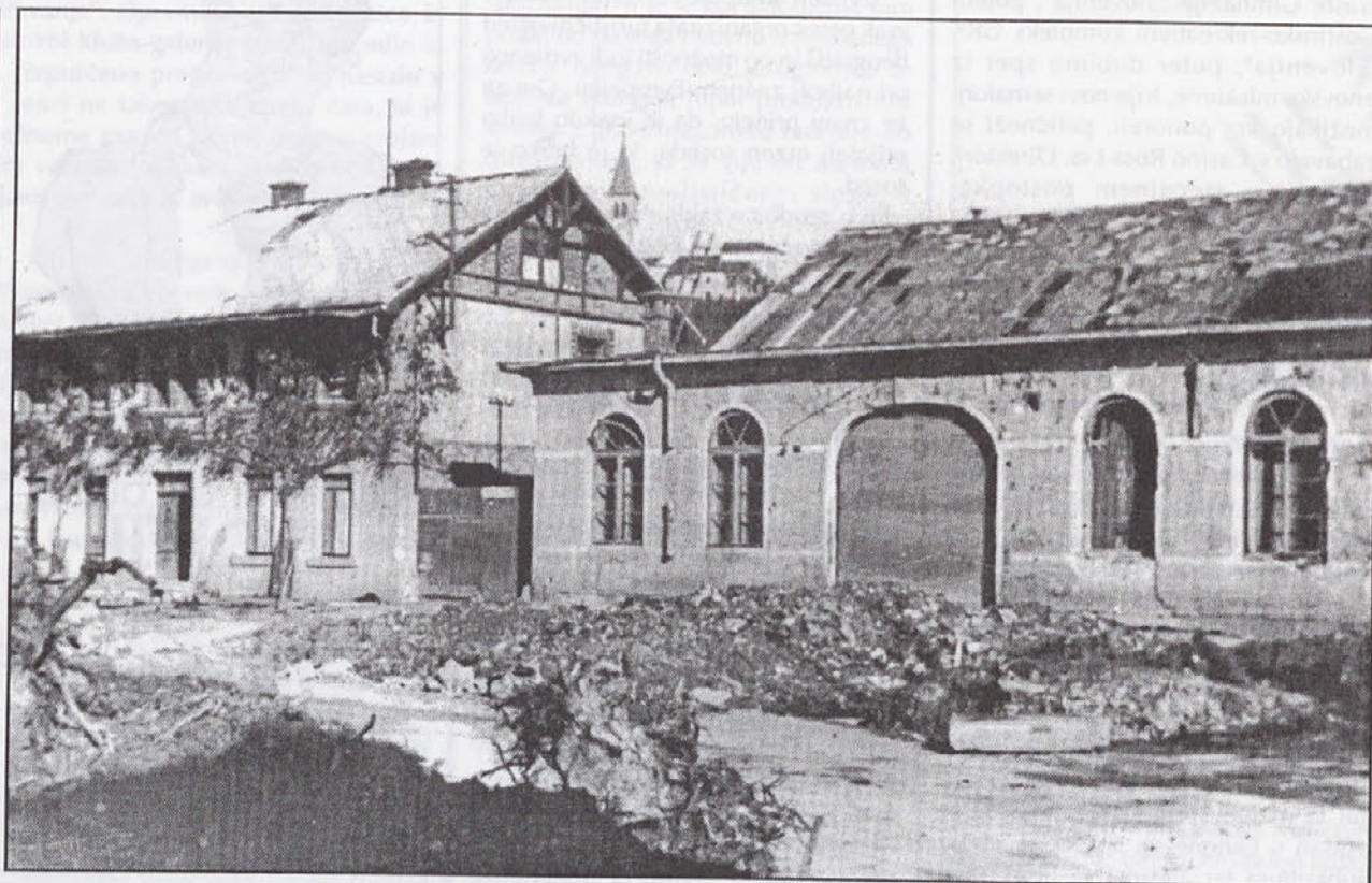
Del križišča pred sedanjim komunalnim podjetjem, fotografiranim nekaj dni po zračnem napadu. Ursusova hiša in garaža sta ostali brez stekel na oknih in vratih, pobralo pa je tudi streho na garaži. Na cesti sta dve veliki jami še dolgo spominjali na strašen dogodek. (Fotografije so delo ateljeja Maraž. Hrani jih Darko Verbič.)
