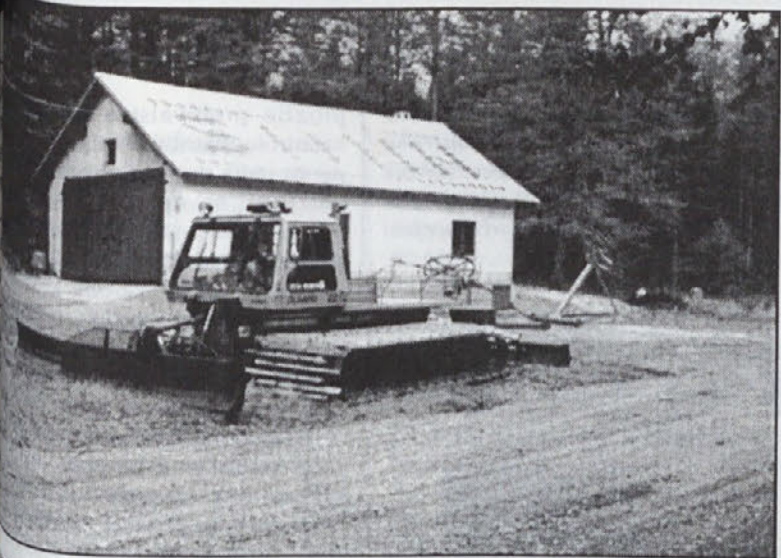
Novljena garaža, teptalni stroj in prenosna vlečnica
