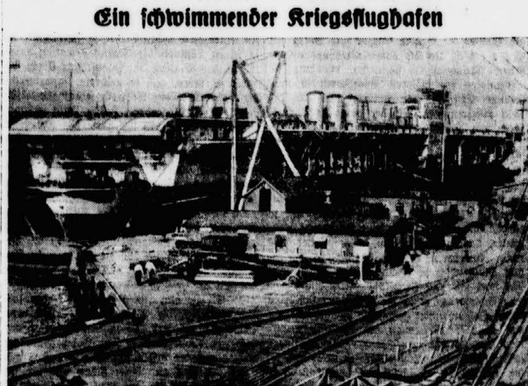
Ein neues amerikanisches Flugzeugmutter schiff, die „Ranger“, für 140 Marineflugzeuge, geht im Dock von Newport (USA) seiner Vollendung entgegen. Der Bau des Schiffes, das etwa 250 Meter Länge mißt, kostete 19 Millionen Dollar. Die „Ranger“ wird 20 1/2 Knoten (54 Kilometer) in der Stunde laufen.
