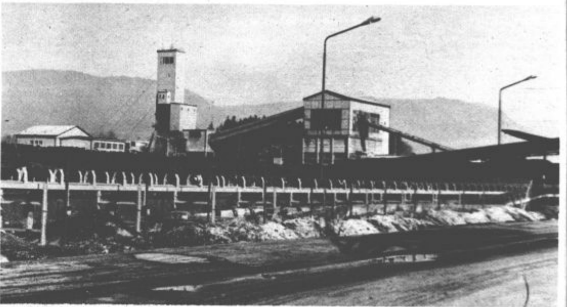
Jašek Preloge so pričeli graditi leta 1947. Z njegovo pomočjo so v zadnjih letih izvozili na površino 11.500 ton lignita na dan.
