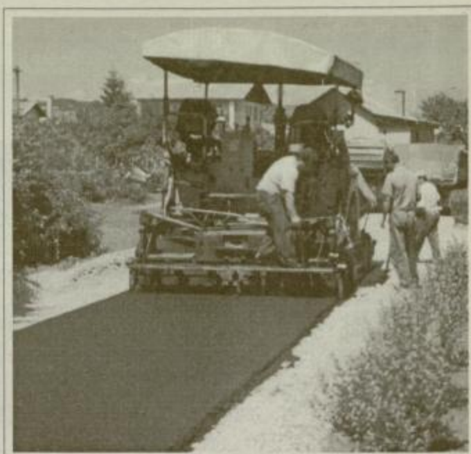
Pri asfaltiranju ceste na Bregu pri Polzeli.
