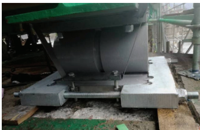
Slika 15 • Montaža objemnih jarmov in opaž za podlivanje ležišč.
