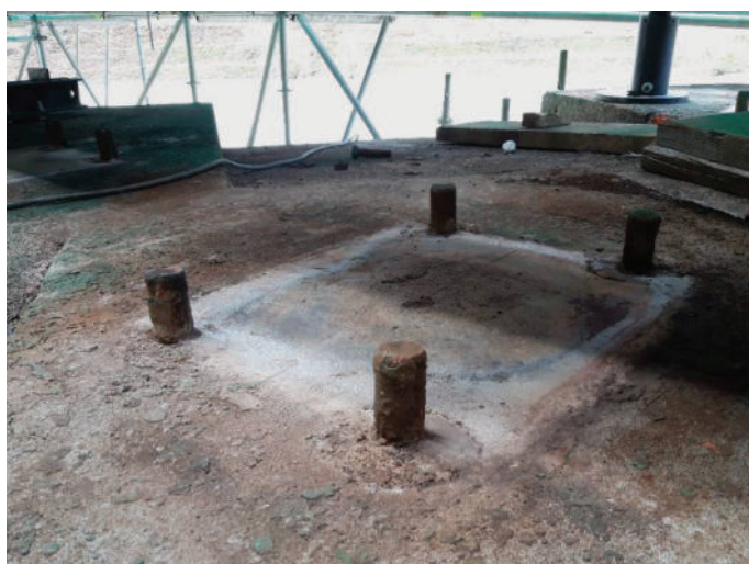
Slika 12 • Stanje na mestu ležišča po odstranitvi ležišča in svinčene plošče.
