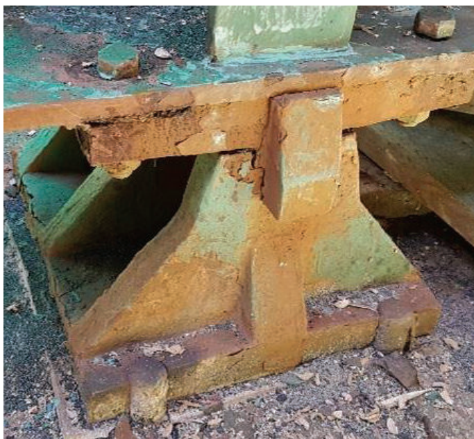
Slika 4 • Nepomično ležišče (levo) in pomično ležišče (desno) pred sanacijo.
