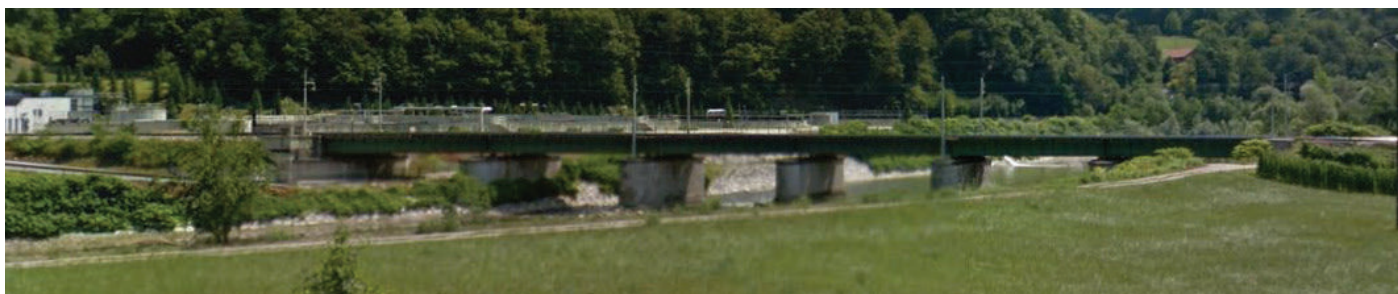
Slika 1 • Pogled na most v km 522+446 z desnega brega Savinje.
