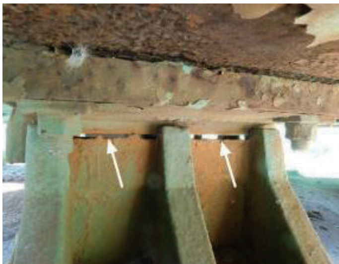
Slika 5 • Zračnost ležišč (9 mm in 8 mm).
