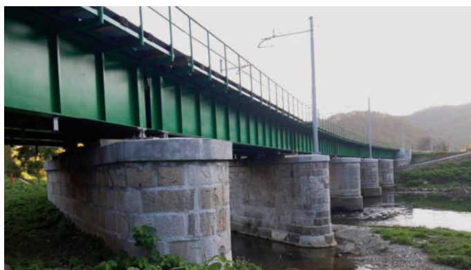
Slika 22 • Most po sanaciji.
