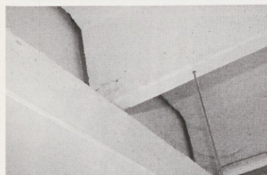
Takole izgleda montažna gradnja. Betonske prečke naslonjene na nosilne stene samo nekaj centimetrov.
