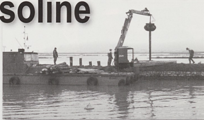
V solinah ocenjujejo stroške sanacije na milijon evrov. Na fotografiji: Sanacija brežine Kanala fazan na Seči.
