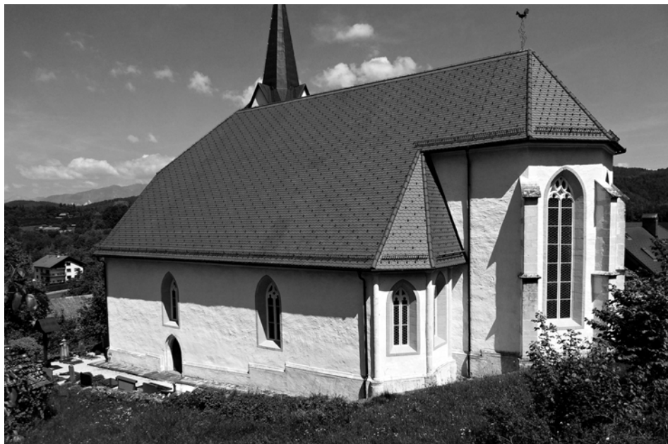
1. Sp. Prapreče, K. St. Lukas, Außenansicht von Südosten
