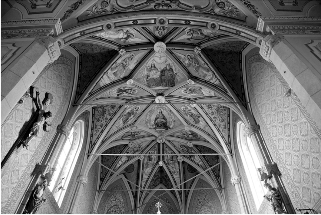
12. Biljana, Pfarrkirche St. Michael, Gewölbe im Presbyterium
