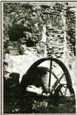
Lončarjeva elektrarna - propadajoči tehnični spomenik
