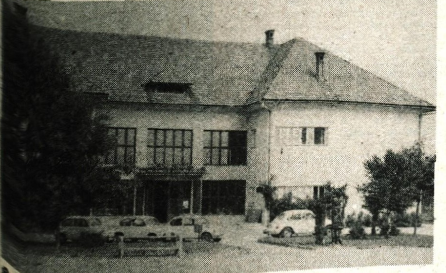
Šola v Mostah kliče po obnovi - Poslopje osnovne šole v Mostah Komendi so zgradili udarniško po vojni. Kaže, da gradnja tedaj ni najboljša, saj poslopje že kliče po temeljiti obnovi. Posebej pomanjkljiv strop v telovadnici, nad katerim so stanovanja. Zaradi nevarnosti, da se strop podre, so telovadnico zaprli, stanovalci pa se morali izseliti. Krajanje Most so se naprej zavzemali, da bi imela skupnost prevzela investicijo: zgradili bi novo telovadnico, v kateri pa bi učenci uporabljali kot jedilnico, v njej pa bi ostal tudi prostor, da bi bil prostor uporaben za razne prireditve. Toda njihova priprava je zavrlo omejevanje investicij, saj je kamniška izobraževalna ustanova morala sredstva za naložbe zmanjšati za 8,36 milijonov na milijonov dinarjev. Vse torej kaže, da bo moč poslopje le obnoviti.
