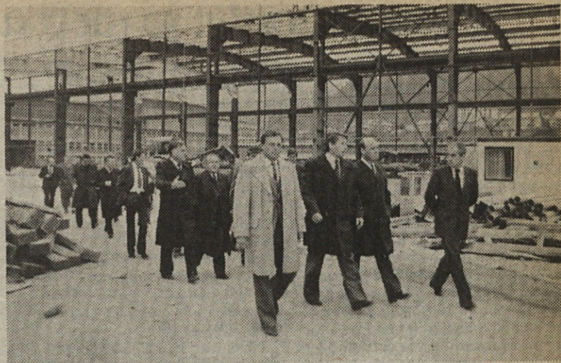
Dušan Šinigoj v času obiska gradbišča Jeklarne 2 (Foto: S. Kokalj)
