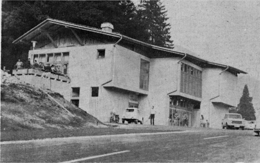
NOVA SAMOPOSTREZNA TRGOVINA V RIMSKIH TOPLICAH Z NOVIM ASFALTNIM CESTIŠČEM, KI POVEZUJE CESTO II. REDA S CESTO PROTI OGEČAM
