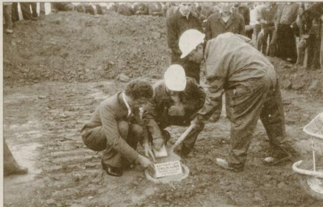
Polaganje temeljnega kamna za tovarno bivalnih zabojnikov na Meleh 1977. leta
