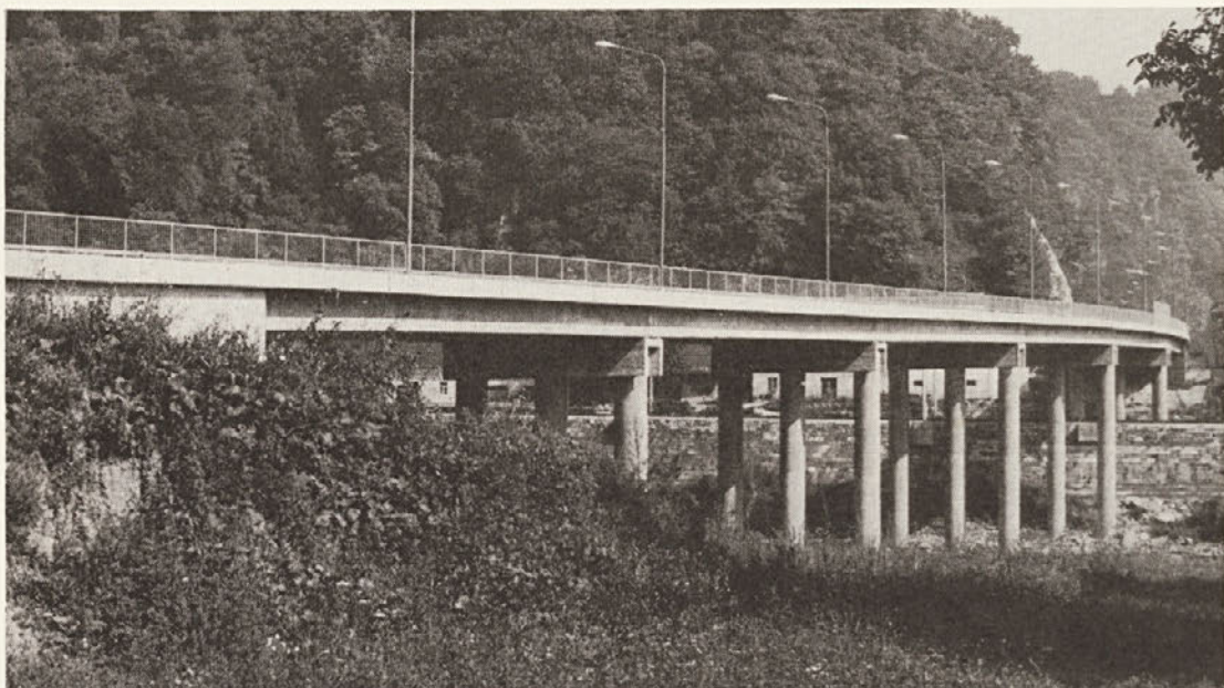
Most v Brestanici so čez Savo in železniško progo krški gradbinci zgradili v rekordnem roku (Foto: Goran Rovani) Most preko Save i železnice kod Brestanice radnici sektora Krško izgradili su u rekordnom roku
