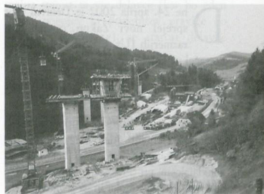
Gradnja AC v Petelinjeku.
