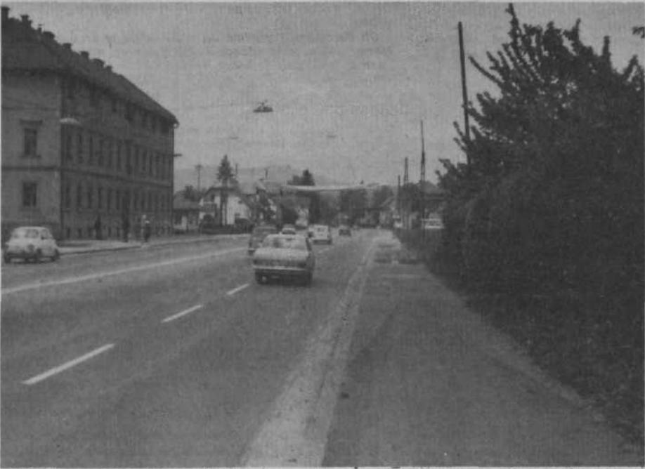
Pločnik brez asfalta – tako bo še nekaj časa, saj bo prav na mestu, ki je na sliki, nekdo Titovo cesto prečkala obvoznica.
