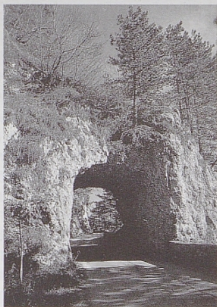
Predor na cesti Lokavec - Predmeja v Trnovskem gozdu.
