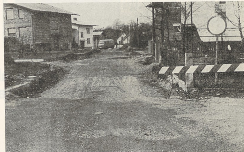
Del Pečinske ulice v Zg. Kašlju ob pripravah za asfaltiranje (foto Ciril Zupančič)
