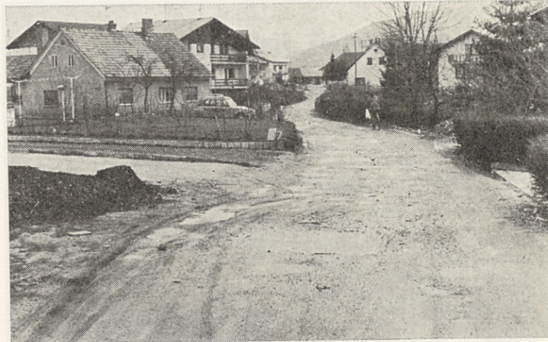
Skojevskva ulica z velikimi lužami pred asfaltiranjem (foto Ciril Zupančič)
