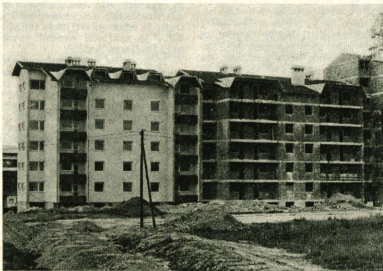
Stanovanjska izgradnja v Domžalah hitro napreduje in prvi del seske ob Kidričevi cesti bo že kmalu dokončan
