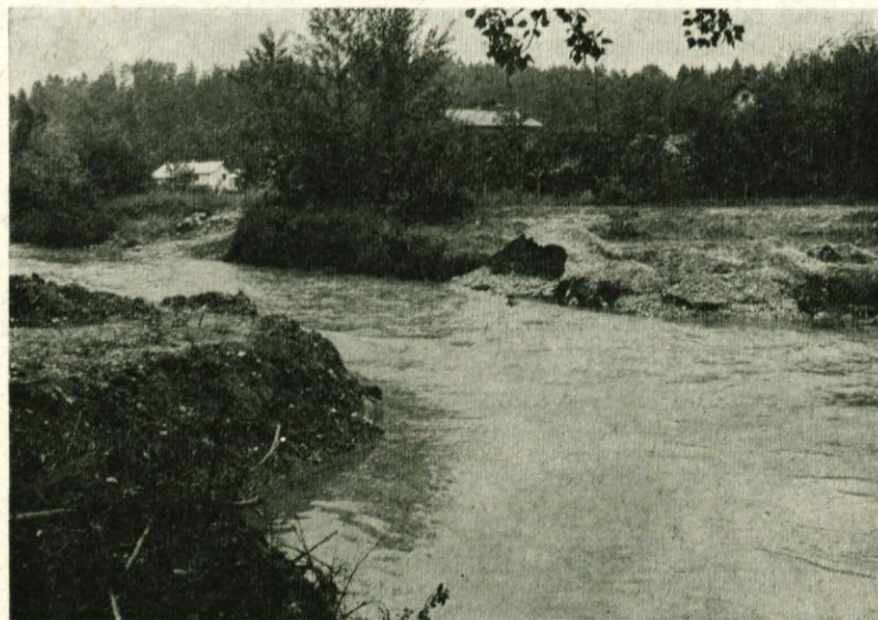
Končno so se začela pripravljala dela za gradnjo mostu preko Kamniške Bistrice
