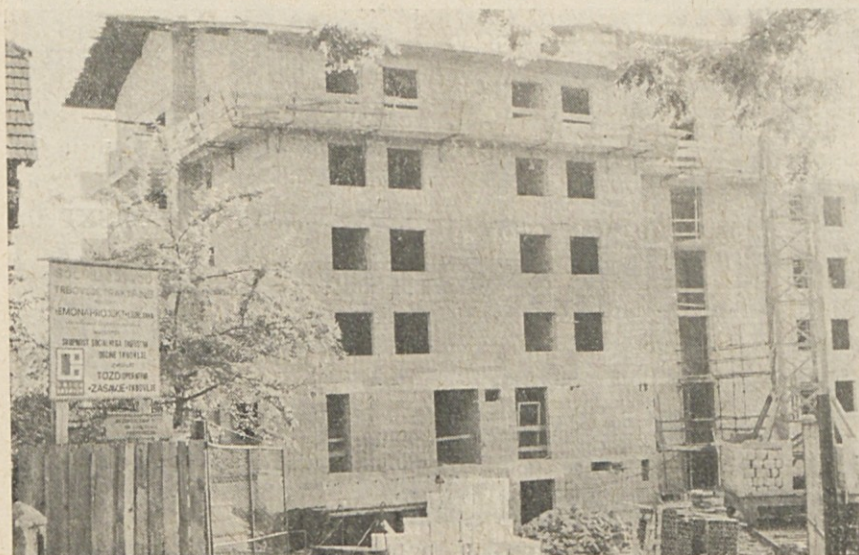
Izgradnja novega socialnega zavoda za upokojence v Trbovljah v Koloniji 1. maja je že pod streho. Pričeli so z vzdavanjem vrat in oken in drugimi gradbenimi in obrtniškimi deli. (Foto A. Bregant)
