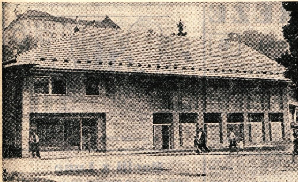
V četrtek, 3. julija, so v Škofji Loki zraven avtobusne postaje odprli novo vozliščno avtomatsko telefonsko centralo v prenovljenem poštnem poslopju. — Foto: F. Perdan
