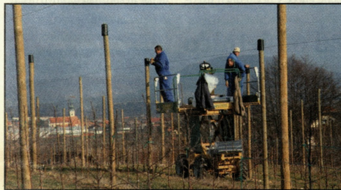
Montaža zaščitnih kap na lesenih stebrih za mrežo proti toči
