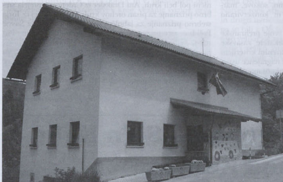
Šola v Šentlambertu je bila ustanovljena pred 130 leti.
